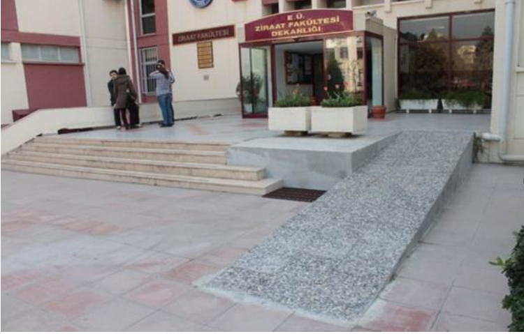
Resim 38: B Blok Engelli Rampası
