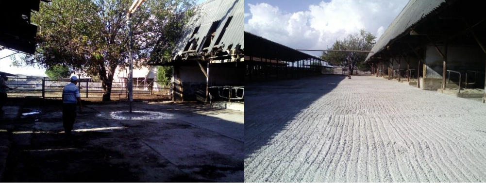
Resim 50: Menemen Büyükbaş İşletmesinde Zemin İyileştirme Çalışmaları
