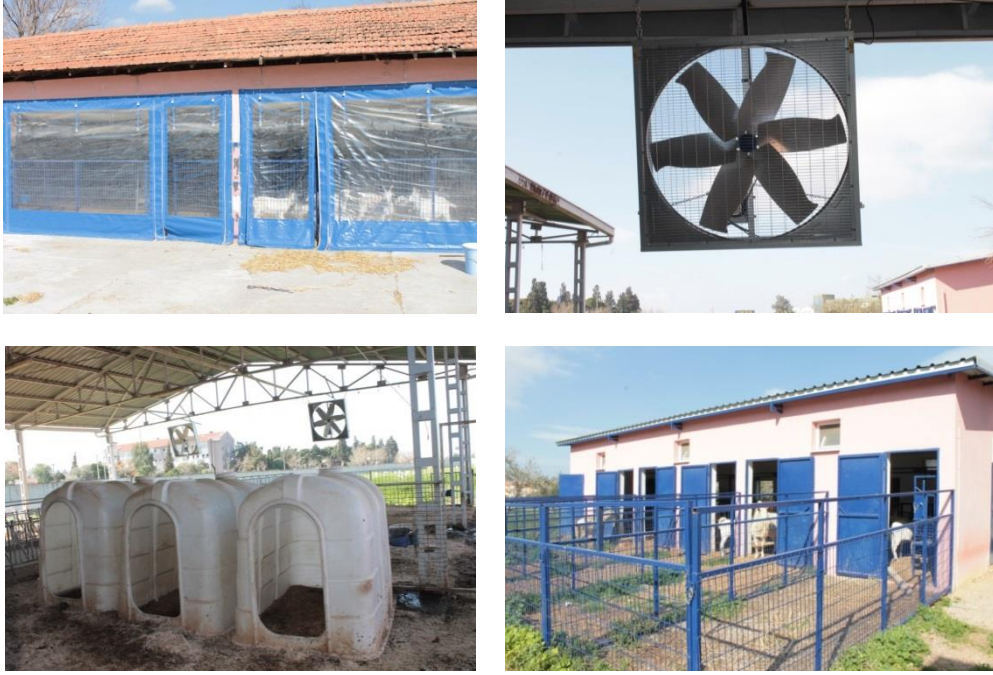
Resim 45: Zootekni Bölümü Tesislerinde Yapılan Yenileştirme Çalışmaları
