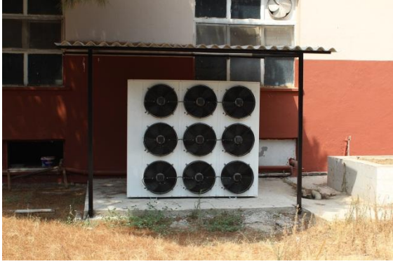
Resim 22. Süt soğutma sistemi
