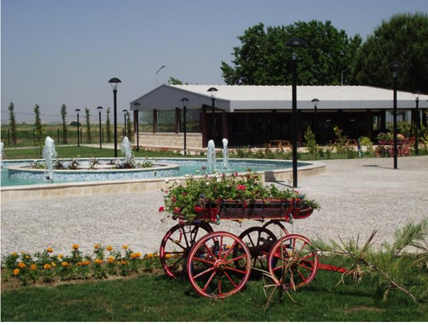
Resim 29. İnşaati tamamlanan restoran
